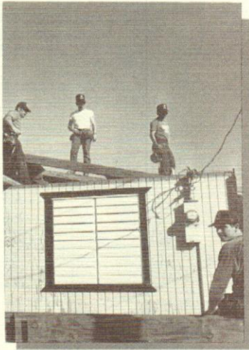
Reparación de casas por mediación del Christian Community Center.
