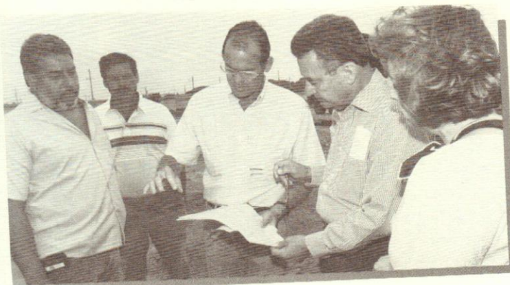
En Estancias de Tierra Alta, en Canóvanas, donde se construyen 42 viviendas, el ingeniero Rubén Véliz, segundo desde la derecha, de la Junta de Directores, y el ingeniero Miguel Vidal, a su lado, de Vifont Builders, cotejan los planos de la obra, junto a doña Lila. Observan, el ingeniero Rafael Vázquez, izquierda, inspector de la Oficina de Vivienda Permanente y el ingeniero José B. Andreu, de Desuja Construction Corporation, desarrolladores de solares.
